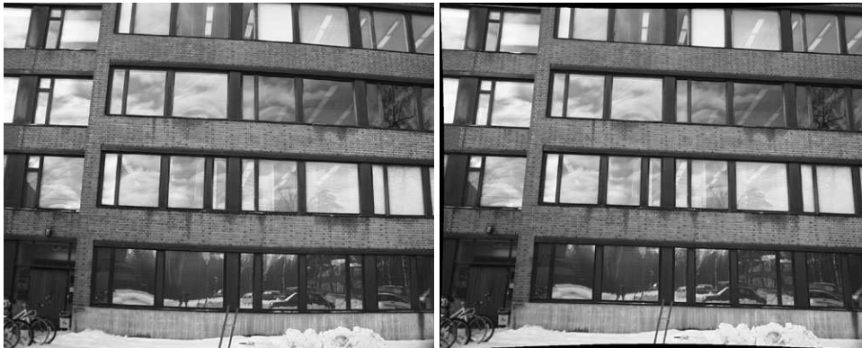
Kuva 12. Vasemmalla on digitaalisella kameralla otettu kuva, josta ei ole poistettu linssivirheitä. Tarkastelemalla seinä- ja ikkunanpuitelinjoja on helppo havaita vääristymiä. Oikealla olevasta kuvasta on poistettu radiaalinen piirtovirhe.
